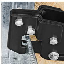
Установка инструмента на оба соединяемых профиля
